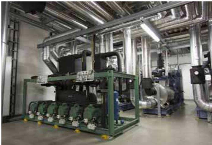
Die CO<sub>2</sub>-Anlage (t<sub>0</sub> = -35 °C) arbeitet ausschließlich im subkritischen Bereich und besteht aus einem Verbund von sechs Kompressoren, die jeweils eine Kälteleistung von 65 kW haben.
