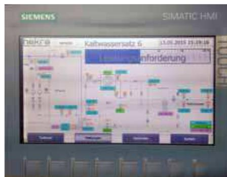
*Die Regelung der Anlage erfolgt durch den Basic Controller Siemens Simatic S7-1200.*
