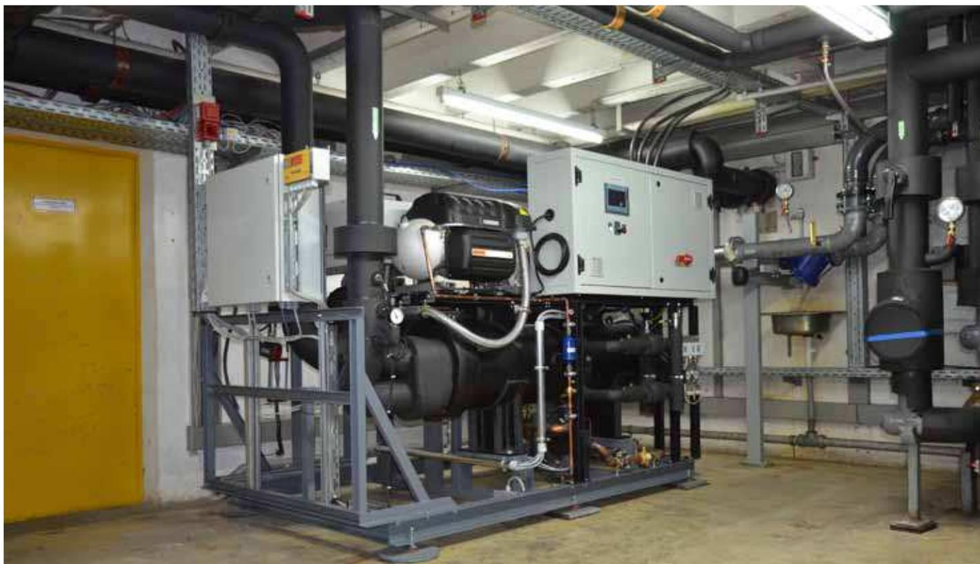
Technikraum mit dem Kaltwassersatz mit ölfreiem Turboverdichter
