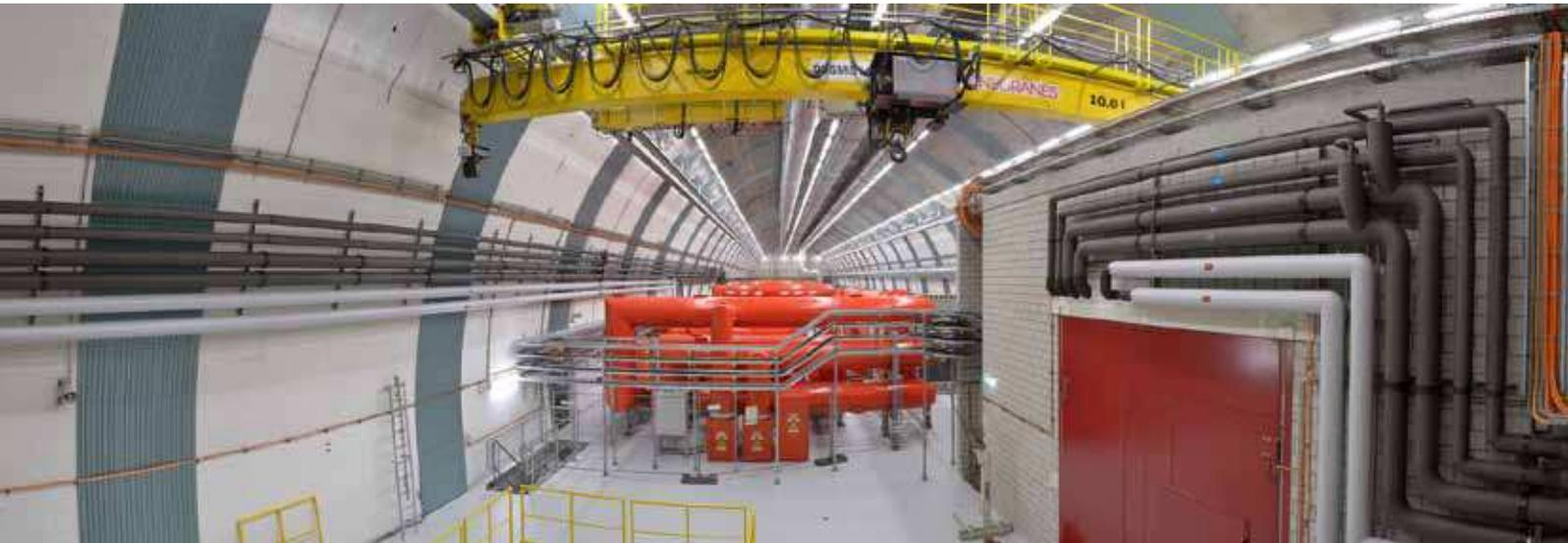
*Dämmarbeiten in der Trafokaverne: Mit „NH/Armaflex“ gedämmte Kühlwasserleitungen. Im Bereich der Abschottungen wurde die Brandschutzbarriere „Armaflex Protect“ eingesetzt. (Die warmgehenden Leitungen wurden mit Mineralwolle gedämmt und PVC ummantelt.)*
