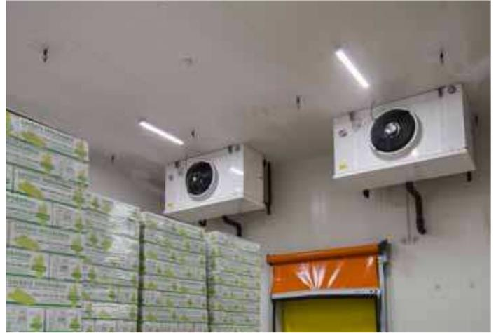
Zwei Tiefkühlräume werden über fünf CO<sub>2</sub>-Direktverdampfer, Typ „CXGHN“, versorgt. Die Abtauung erfolgt über einen separaten, integrierten Warmsolekreislauf.
