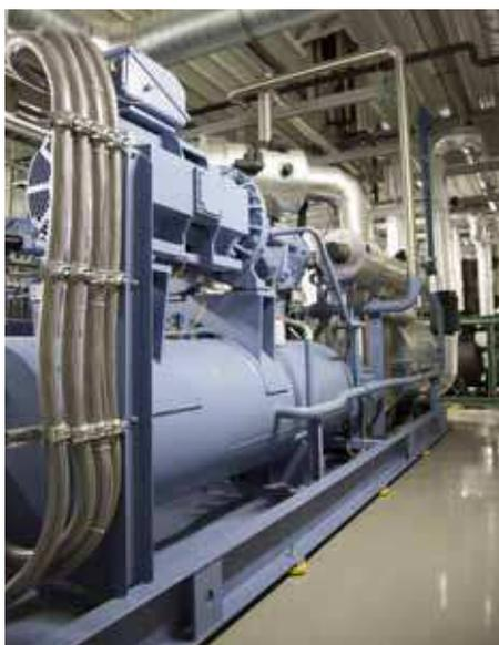
Zur Kälteerzeugung sind drei NH<sub>3</sub>-Flüssigkeitskühler mit Schraubenkompressoren und je 600 kW Kälteleistung installiert. Zwei dieser Geräte stellen Kaltsole mit -11 °C/-5 °C für die Kühlräume zur Verfügung, und ein NH<sub>3</sub>-Flüssigkeitskühler stellt Kaltsole mit -1 °C/5 °C für die Klimakälte zur Verfügung.
