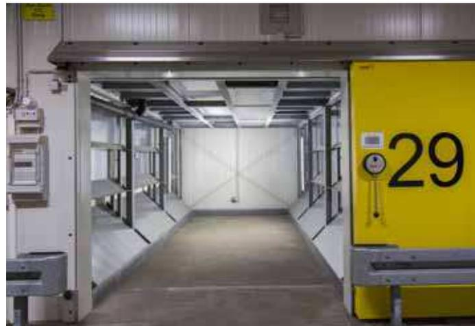
Um im Schockfroster eine gleichmäßige Verteilung der Luft durch das Gefriergut – z. B. Süßmais Kolben – zu gewährleisten, führen Luftleitbleche die kalte Luft durch das Gefriergut.
