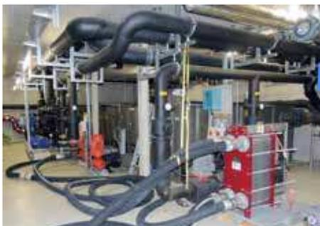
Besonders leistungsfähiger Plattenwärmetauscher im Einsatz
