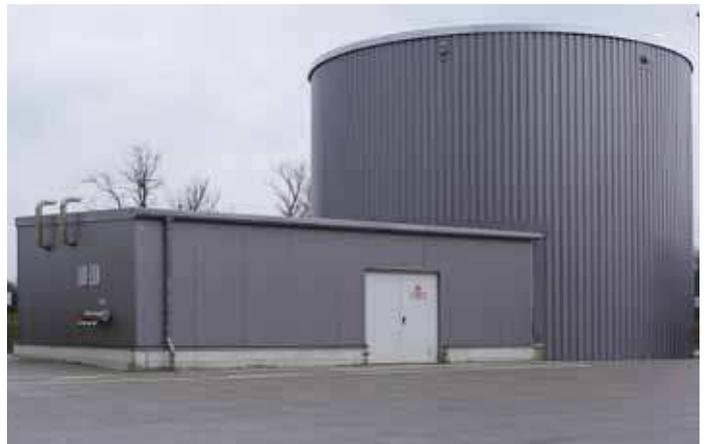
Sprinklerwassertank/Pufferspeicher für Wärmerückgewinnung
