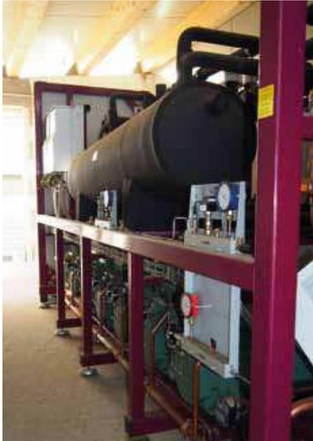
„ROXSTA industrial“-Kältemaschine in der Kältezentrale
