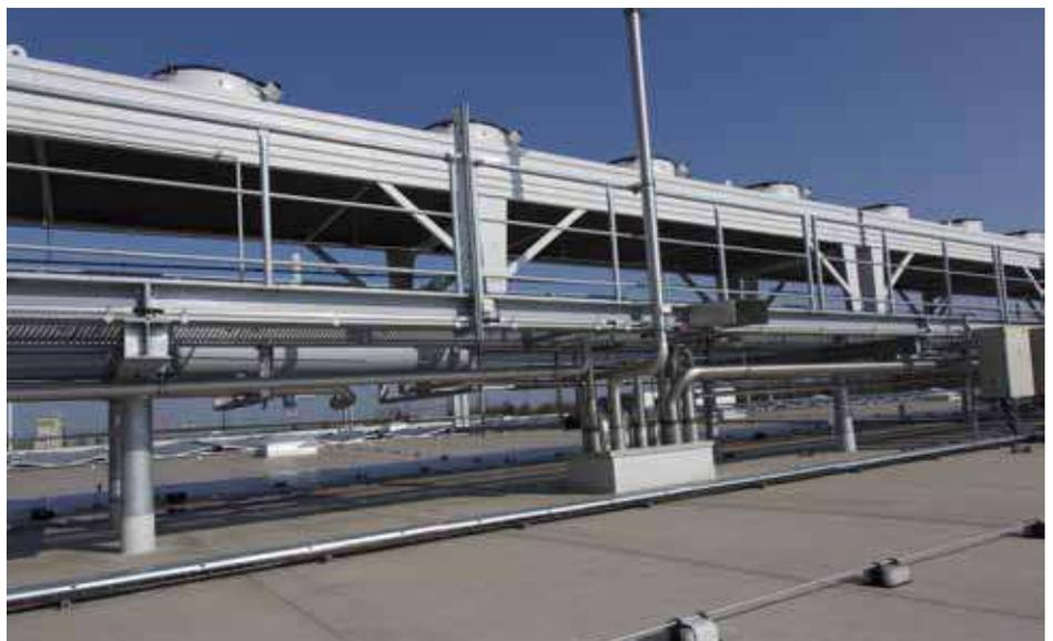
*Die Verflüssiger haben eine Leistung von zusammen 3.100 kW und stehen in einem Verbund auf dem Dach neben der Photovoltaik-Anlage.*
