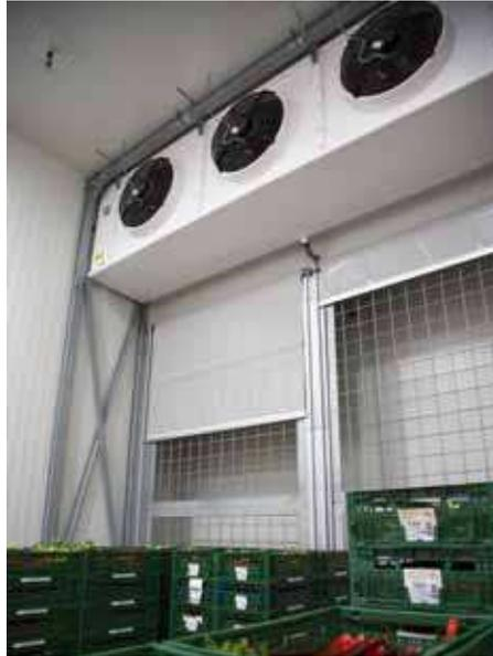
*In den Schnellkühlräumen wird der Luftstrom mit beweglichen Folienblenden gelenkt.*
