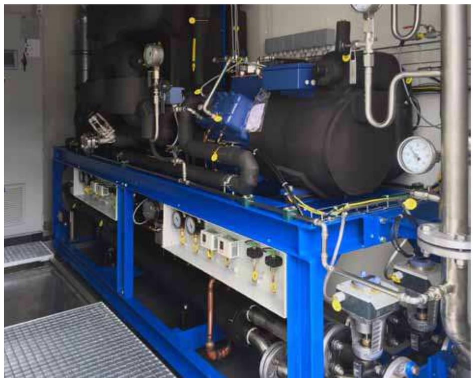
*Die Kälteanlage für die Pharma-Industrie erzeugt Tiefkälte im Bereich von -15 bis -35 °C und arbeitet mit dem natürlichen Kältemittel Propen.*
