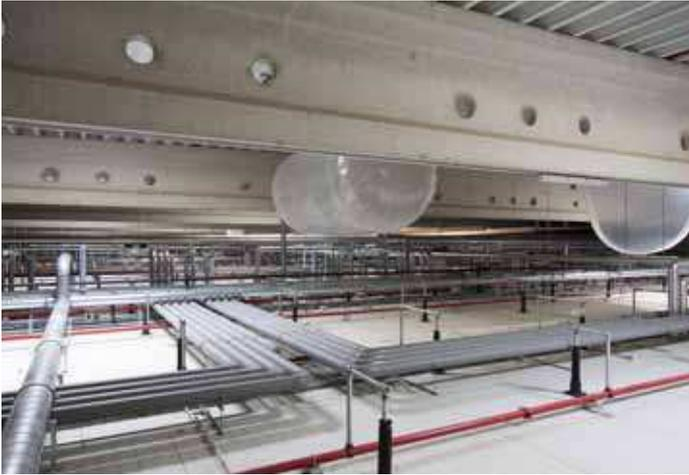
Die umfangreiche Verrohrung, die Luftsäcke der CA-/ULO- Druckausgleichsanlage sowie die Trockensprinkler-Anlage befinden sich oberhalb der Lagerräume.
