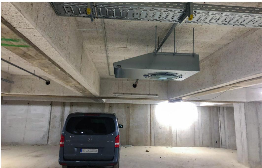
Bild 11: Jet Ventilatoren dienen zur gezielten Belüftung in unzureichend durchströmten Bereichen
