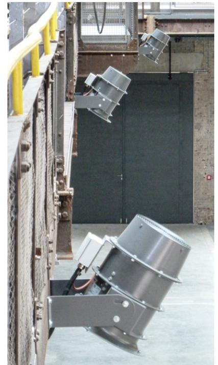
Bild 6b: Impulsventilatoren an der Galeriebrüstung
