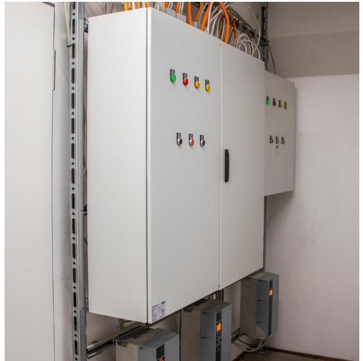
Bild 13: Steuerung für Druckbelüftungsanlage – RaumFabrik Karlsruhe
