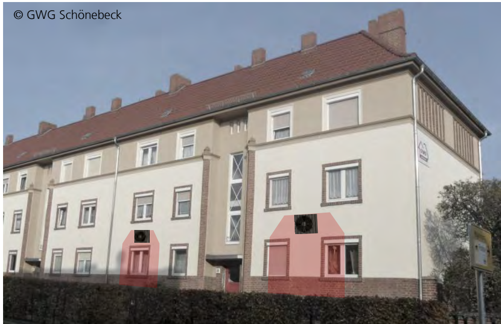
Abbildung 121: Fassade der Leipziger Str. 27 mit Außeneinheiten und propanbedingten Schutzabständen. Bildquelle: GWG Schönebeck, bearbeitet
