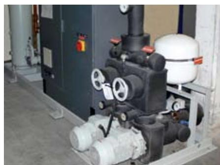
2006 investierte Riwisa für die Klimatisierung einer weiteren Reinraumfertigung in eine gwK-Kältemaschine mit Kondensator
