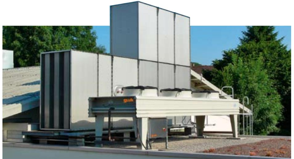
1994 kam dann die erste große Kühlanlage für das Becherwerk mit kombiniertem „Hermeticool“-Betrieb zum Einsatz
