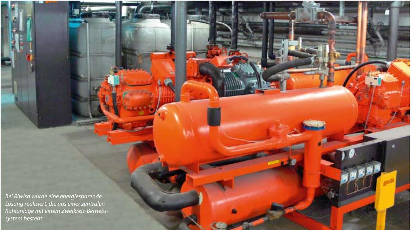
Bei Riwisa wurde eine energiesparende Lösung realisiert, die aus einer zentralen Kühlanlage mit einem Zweikreis-Betriebssystem besteht
