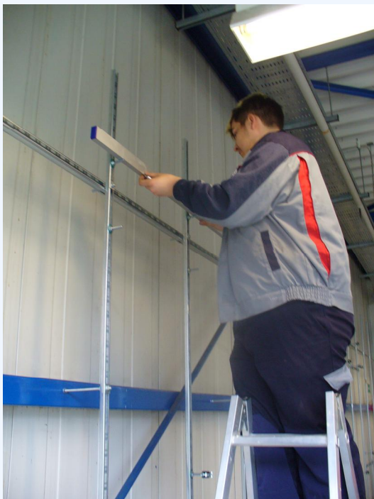
Vorbereitungen für eine Kaltwasserinstallation
