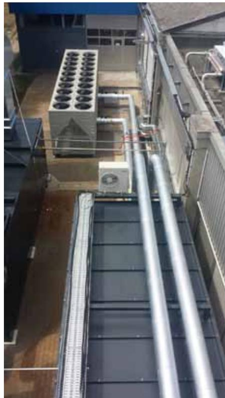
Die beim Kälteprozess der Absorptionskältemaschine entstehende Absorptionswärme wird an einen Kühlwasserkreislauf abgegeben ...
