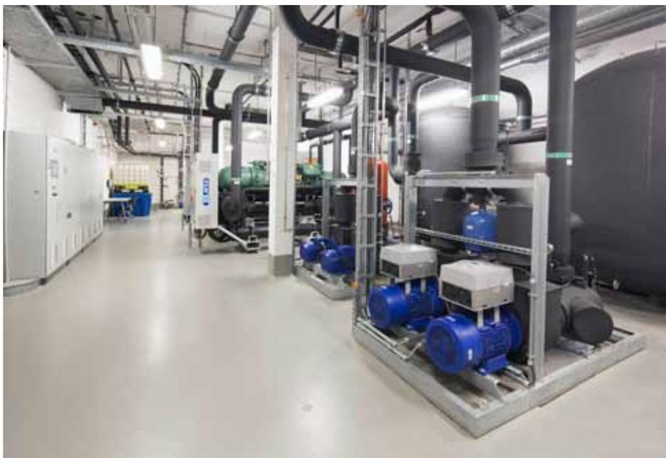
Von rechts nach links: Schichtenspeicher, Pumpenstationen, Kältemaschinen „AQP 2502“ und Schaltschrank
