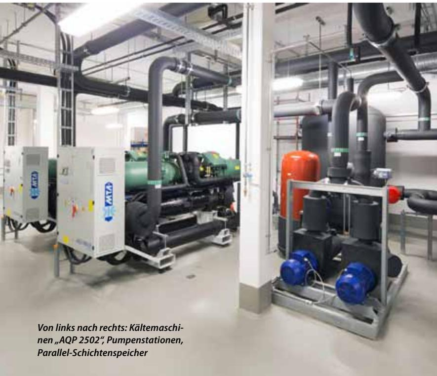
Von links nach rechts: Kältemaschinen „AQP 2502“, Pumpenstationen, Parallel-Schichtenspeicher
