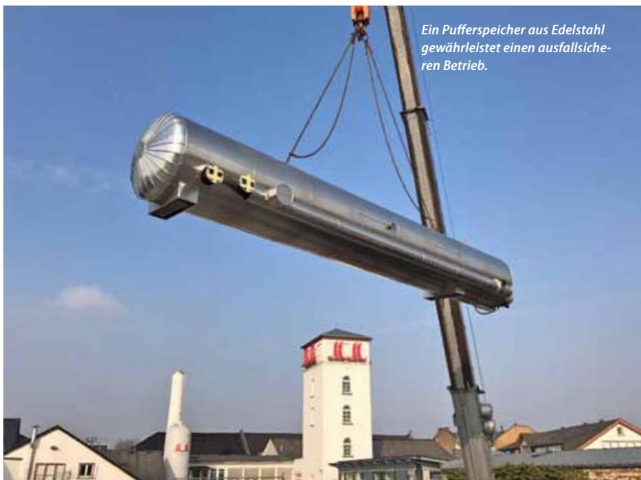
Ein Pufferspeicher aus Edelstahl gewährleistet einen ausfallsicheren Betrieb.
