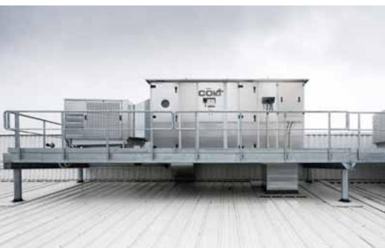
Colts Lösung: Eine Mischung aus dem adiabatischen Kühlsystem „CoolStream“ und einer Be- und Entlüftungsanlage
