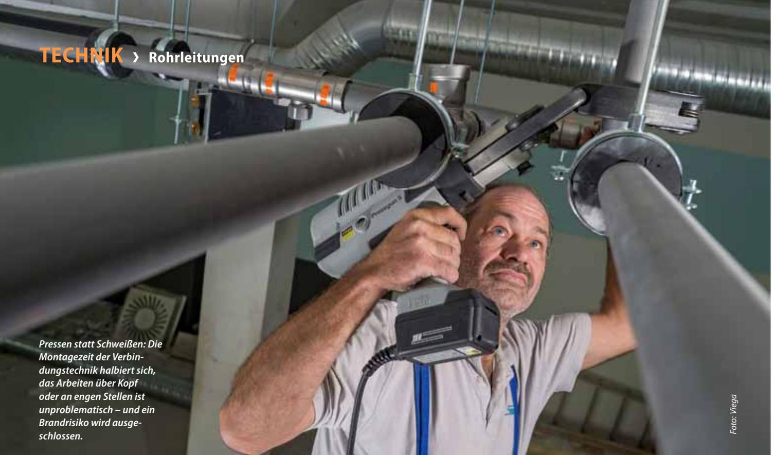
*Pressen statt Schweißen: Die Montagezeit der Verbindungstechnik halbiert sich, das Arbeiten über Kopf oder an engen Stellen ist unproblematisch – und ein Brandrisiko wird ausgeschlossen.*
